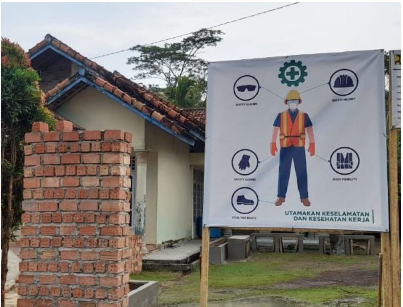
Proyek Infrastruktur Hunian Hijau di Mesuji
